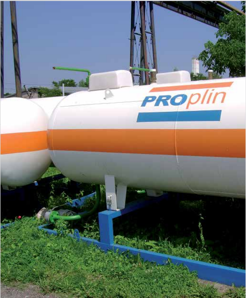
PROJEKT: NADZEMNÍ PLYNOVÉ ZÁSOBNÍKY APLIKACE: "ĎURO ĎAKOVIČ" ZAVARENE POSUDE, SLAVONSKI BROD
