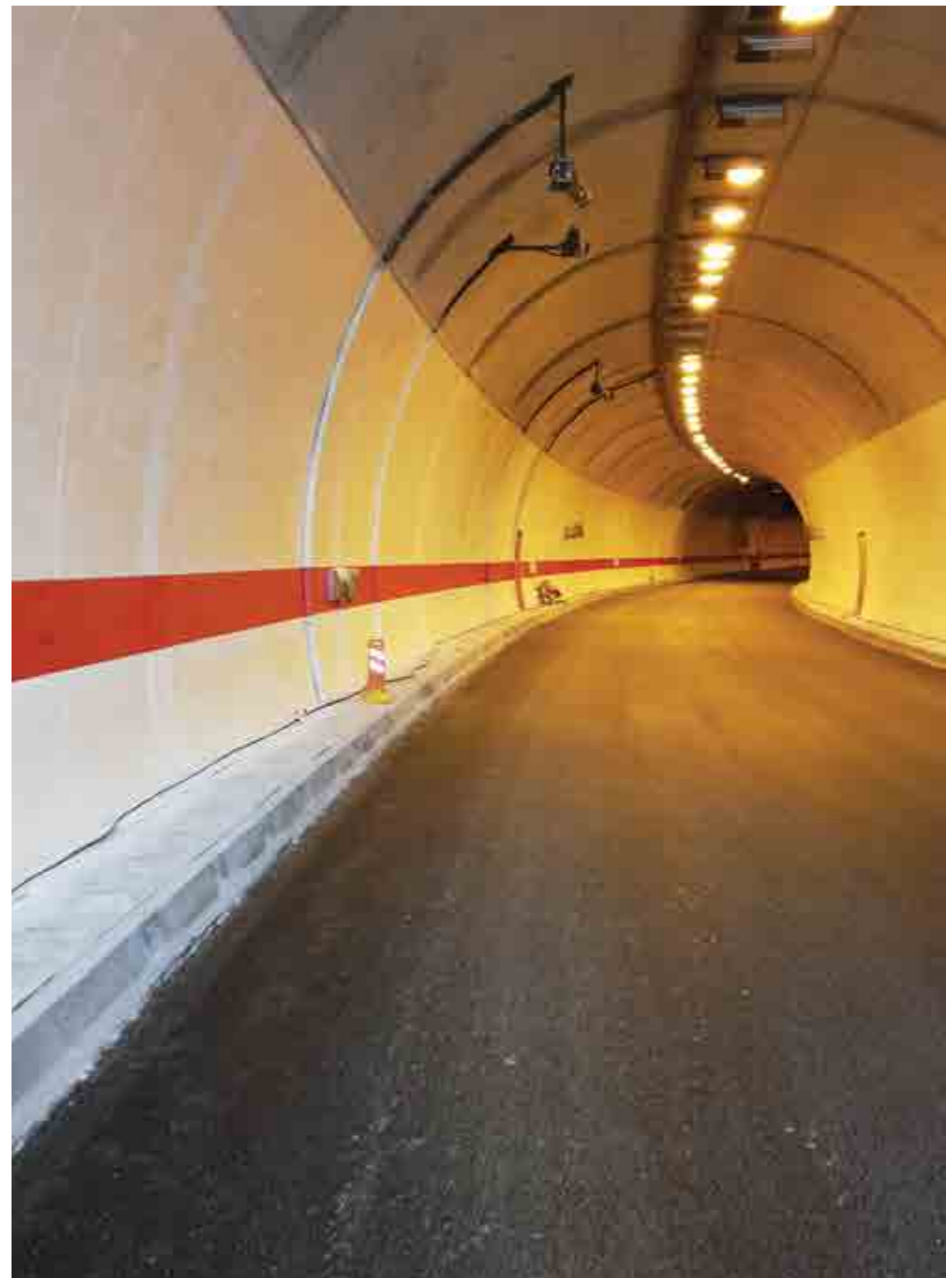
LOKACIJA: tunel Ledenik
