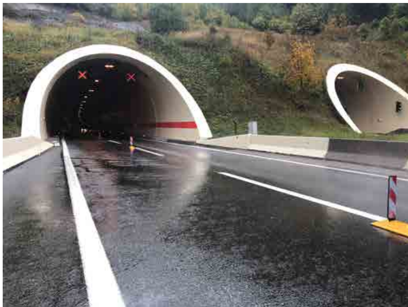
LOKACIJA: tunel Ledenik
